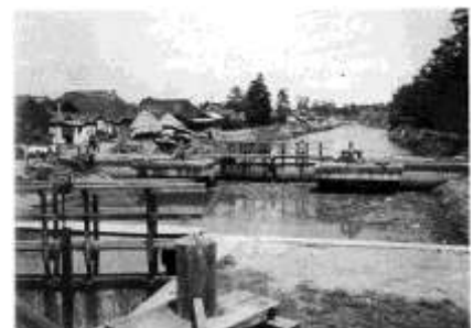
昭和30年ごろの蒲生閘門 閘門と閘門の間は水深が深くプールかわりに最適だったそうです。
