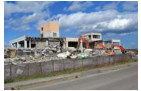
中野小学校（解体時） 小学校を模した避難タワーと継承施設県を作る。
